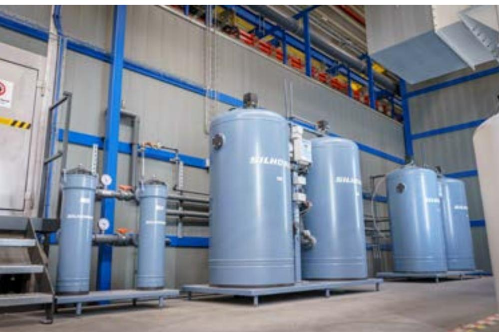
*Вода DI для предварительной обработки без хрома. Промывную воду рециркулируют через ионообменные деминерализаторы. Впереди два мешочных фильтра для удаления механических примесей.*
