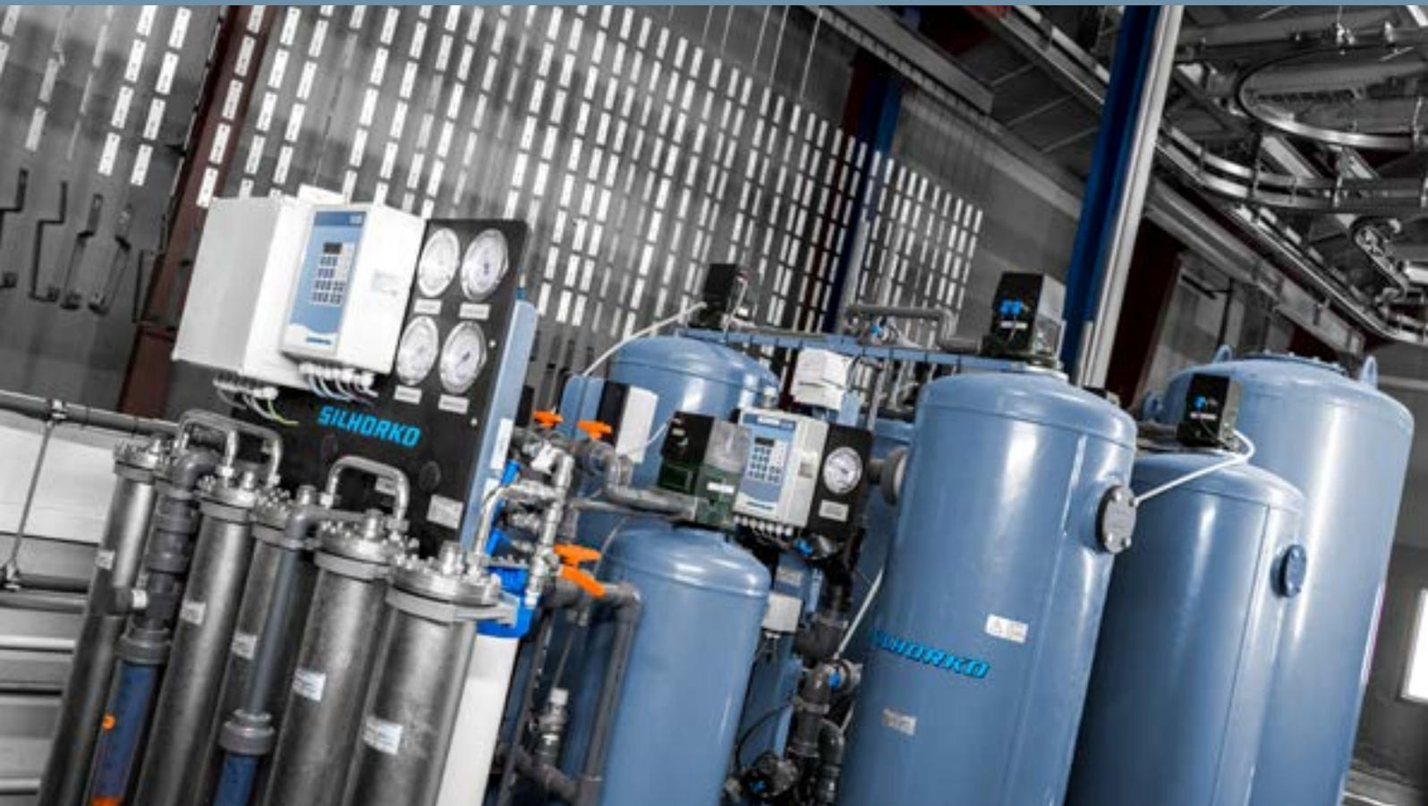
*Предварительная подготовка поверхности DI водой, без содержания хрома, для покрытия алюминием. Решение подпиточной воды состоит из умягчения и обратного осмоса. Рециркуляционная часть включает фильтрацию активированным углем и деминерализацию на ионообменниках.*
