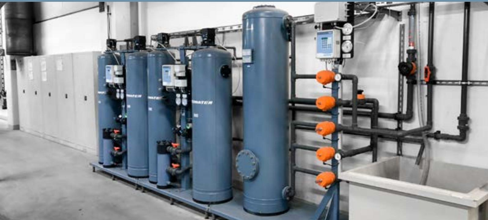
*DI вода для зон полоскания в колесных дисках. Правильно продуманный процесс утилизации воды снижает потребность в свежей воде, а также потребность на очистку сточных вод. Вода из зоны промывки повторно проходит через автоматические гравийные фильтры и два параллельные автоматические деминерализатора. Продукты EUROWATER для систем поверхностной обработки не содержат веществ, портящих краску, в том числе силикона.*
