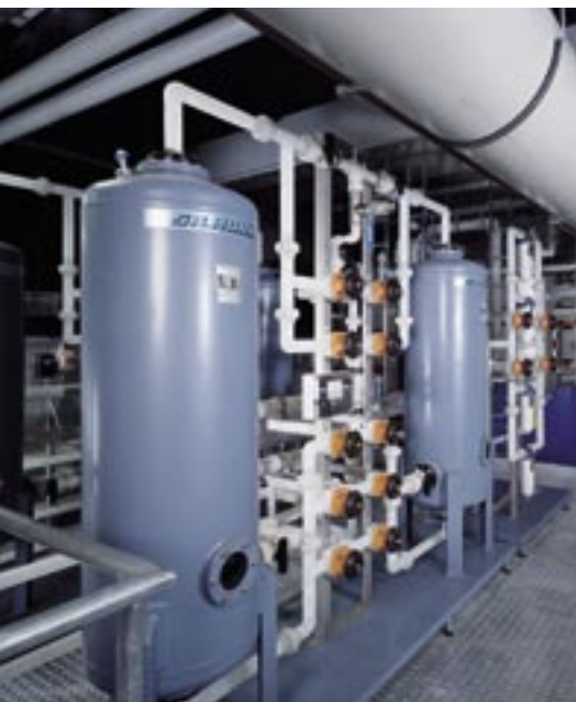
Установка по получению ультрачистой воды. Ультра чистая вода используется для производства полупроводников и компонентов оптики.
